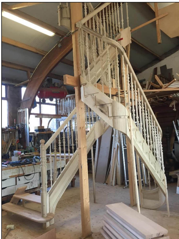
Opstellen van trapdelen in de werkplaats voor controle op passing en juiste maatvoering met aansluitingen
